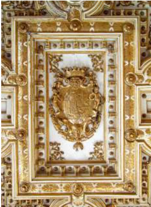
Particolare di una decorazione del soffitto con ritratto lo stemma dei Borbone di Napoli
